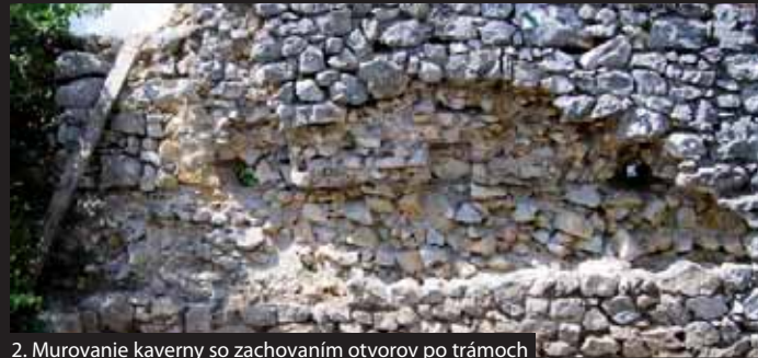
2. Murovanie kaverny so zachovaním otvorov po trámoch
