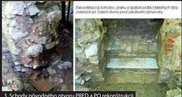
3. Schody pôvodného otvoru PRED a PO rekonštrukcii
