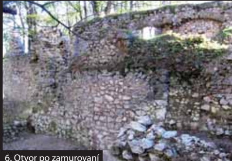
6. Otvor po zamurovaní
