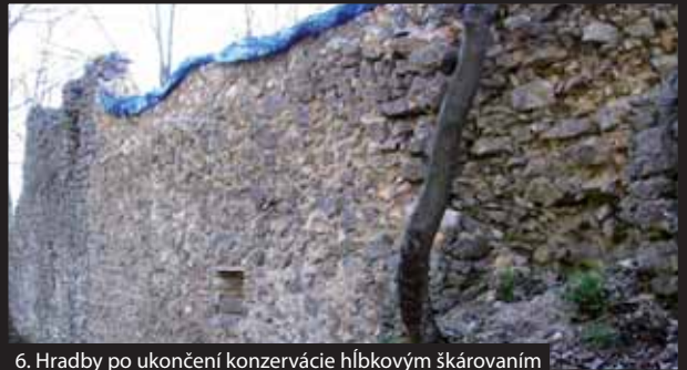
6. Hradby po ukončení konzervácie hĺbkovým škárovaním
