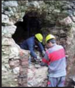
5. Murárske práce na zaslepení otvoru pre stabilizáciu steny
