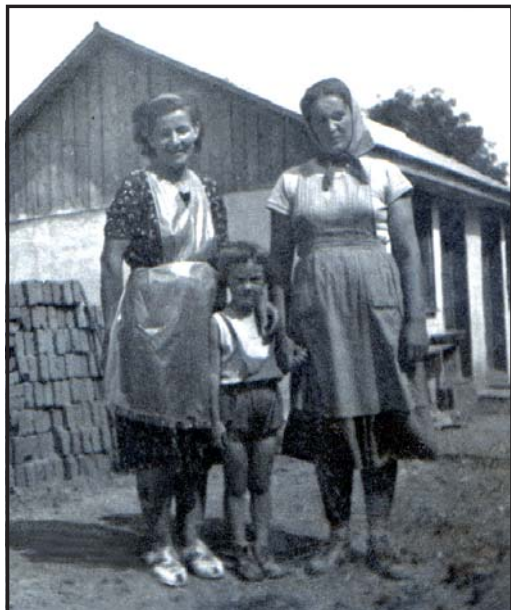
FOTO RS. Muránske guľki chutili aj murárom, ktorí v 60. rokoch stavali prvý štvorbytový činžiak na „Novej ulici“. Na zábere kuchárka Margita HAJDÚKOVÁ a pracovníčka na stavbe Barbora FRANDELOVÁ s dcérou Lubkou. Budova v pozadí (teraz dreváreň) slúžila ako jedáleň a druhá podobná hneď vedľa ako ubytovňa murárov.
