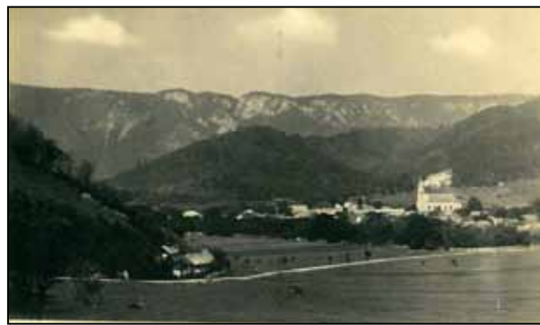
Na zábere z roku 1949 cesta z Muráňa do Muránskej Lehoty okolo bývalej rómskej osady Príslop. (Z korešpondencie Dezidera Garlátiho.)
